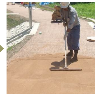
ディアソイル間詰め
